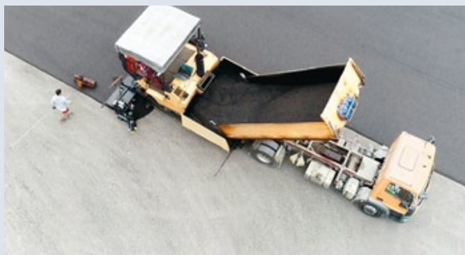
3. KONSTRUKTION: Auf einem Hockeyplatz in Krefeld wird ein elastischer Unterboden von Polytan verlegt. Zutaten: Gummigranulat und der CO 2 -basierte Binder.
